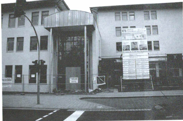
Der Baufortschritt ist deutlich zu erkennen. Die Glaspassage bildet den neuen Eingangsbereich der Bank und verbindet gleichzeitig die beiden Gebäude.
